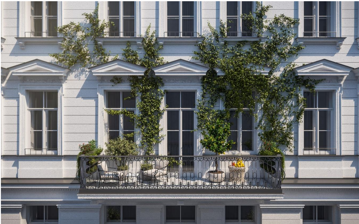
Nachträglich angebauter Balkon inklusive Begrünungssystemen
